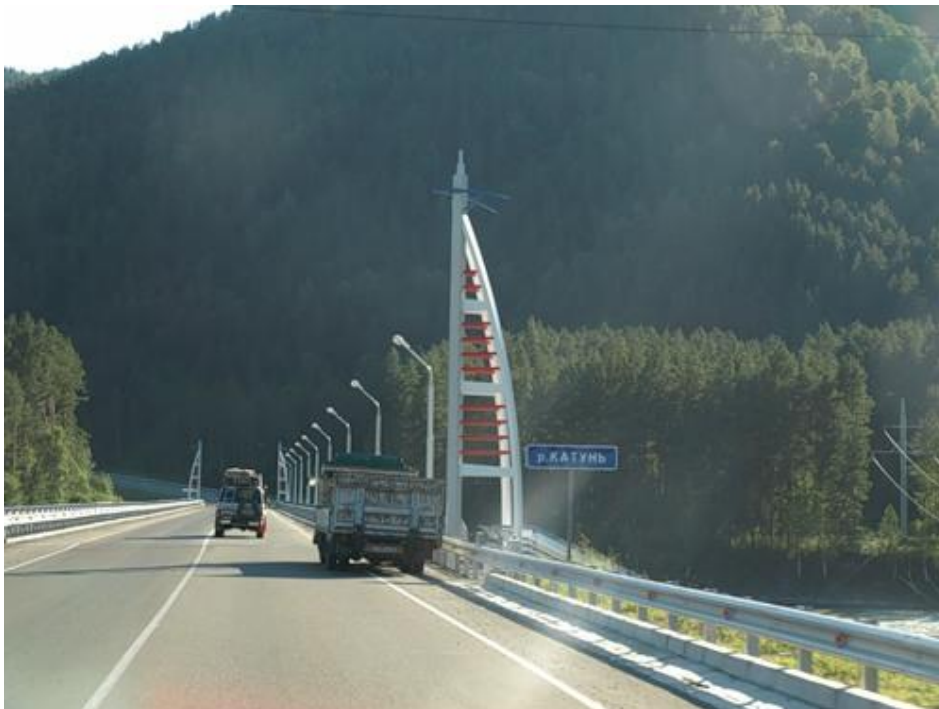
«Новый мост через Катунь»
